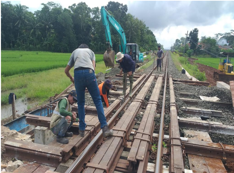
Pek. Bongkar Rel Bendel BH03
