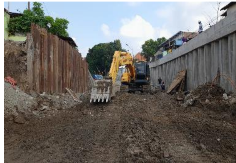
Pekerjaan langsir tanah jalan viaduct, penurunan elevasi.
