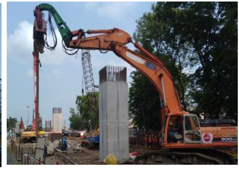
Pekerjaan Pemancangan SSP
