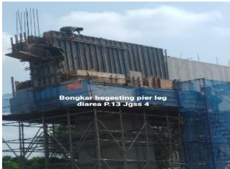
Pekerjaan bongkar bekisting pier leg P.13
