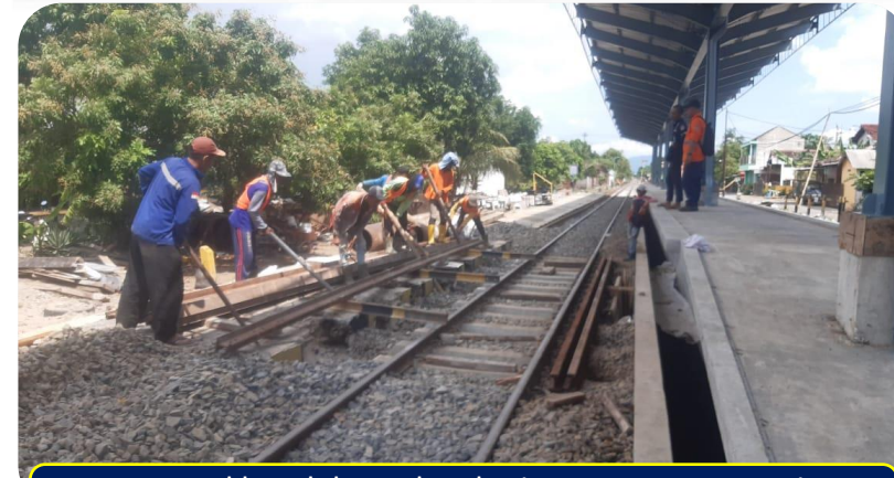
Pasang rel bendel untuk pekerjaan pemasangan pipa besi jalur kawat sinyal depan PPKA St. Sukoharjo
