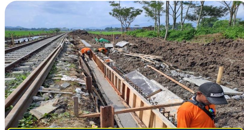
Pembesian & bekisting RW di km 18+925
