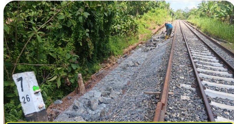
Pemasangan batu bronjong km 26+650-700
