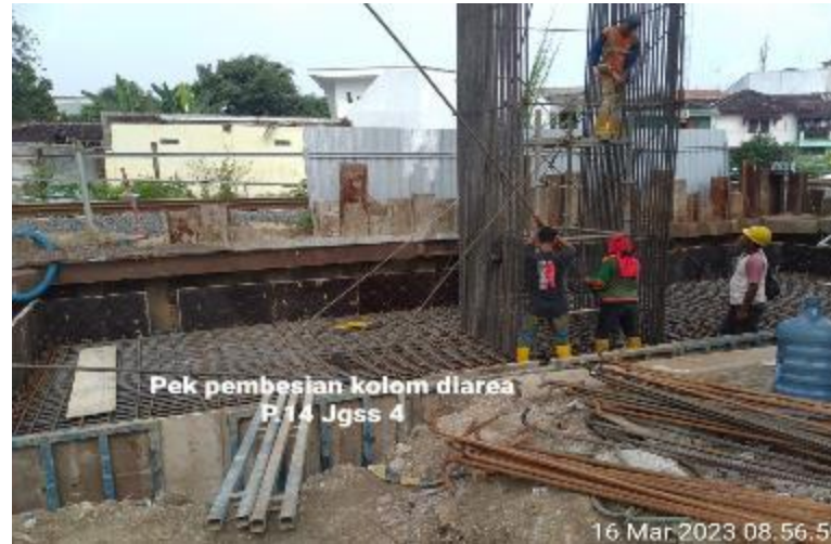
Pekerjaan pembesian kolom P.14
