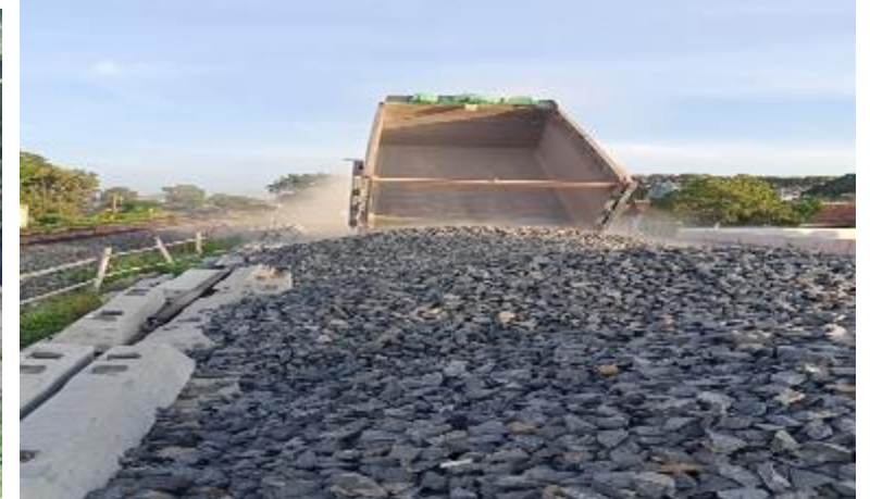
Pekerjaan gelar balast
