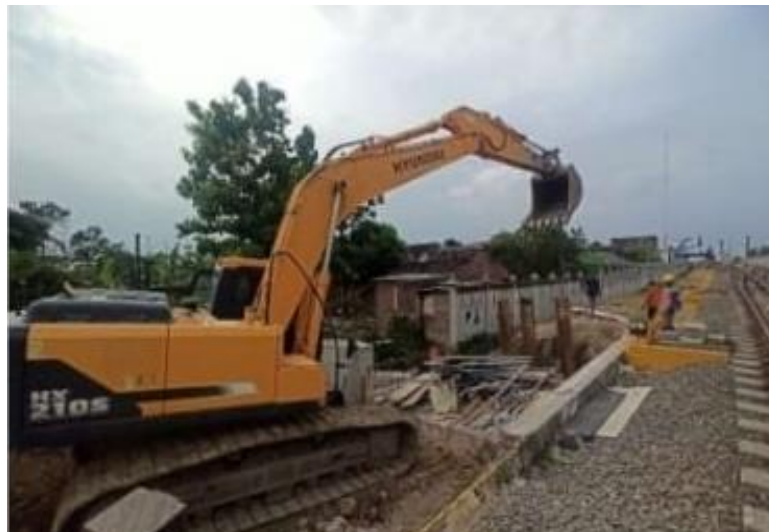
Pekerjaan pembesian plat ijinak
