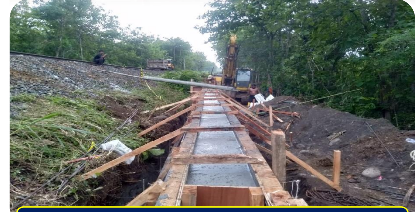
Pengecoran dinding RW Km 27+050
