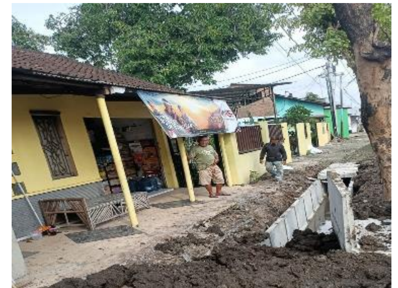
Pekerjaan drainase pracetak
