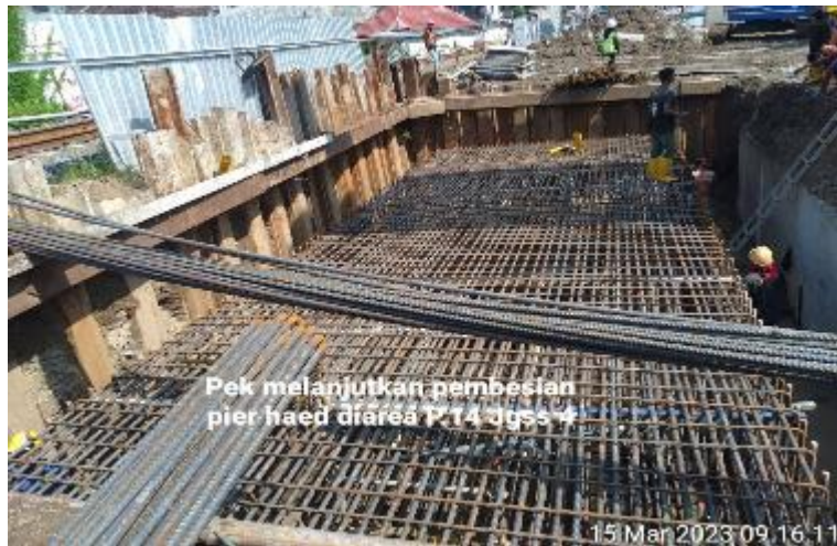
Pekerjaan pembesian pier head P.14
