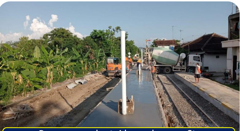
Pengecoran lantai konsol peron St. Pasarnguter
