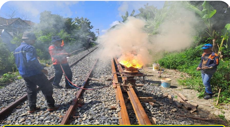
Las thermit km 13+750
