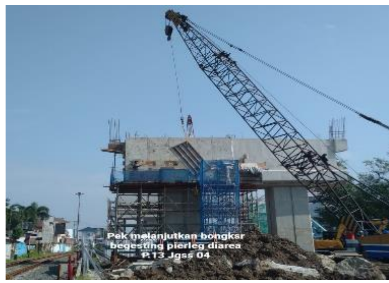
Pekerjaan bongkar bekisting pier leg P.13
