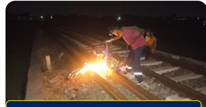
Pekerjaan pengelasan Rel R. 54
