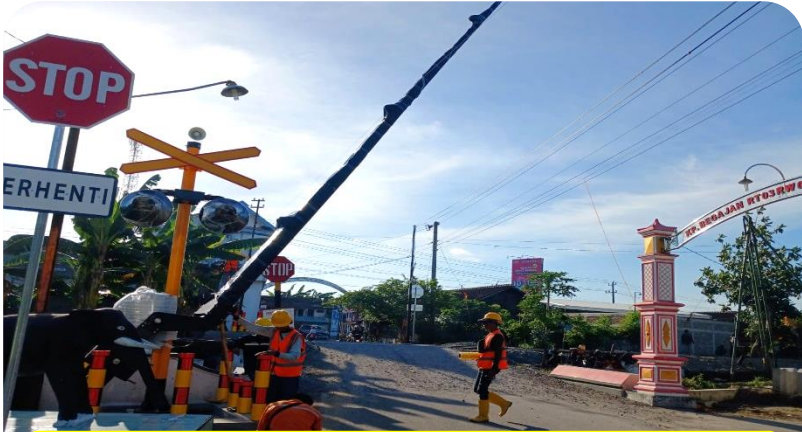
Proses Pemasangan Palang Pintu JPL 21
