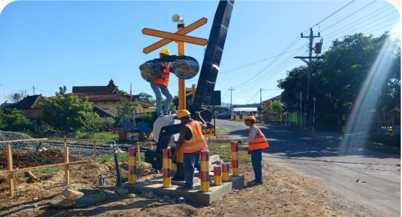
Proses Pemasangan Palang Pintu JPL 28
