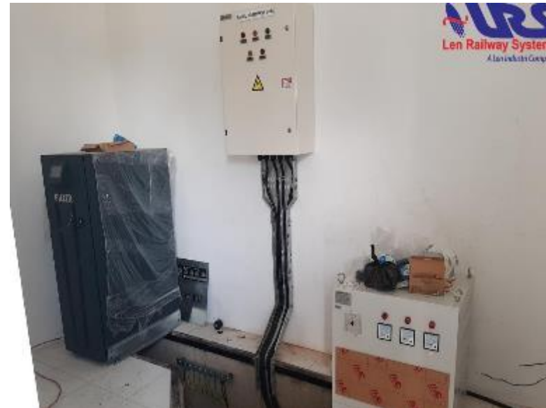
Pekerjaan pangadaan catu daya
