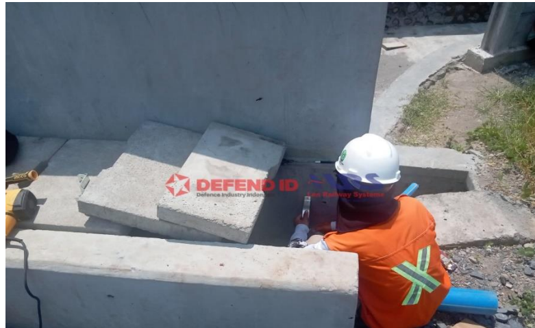
Pekerjaan Pemasangan pipa HDPE
