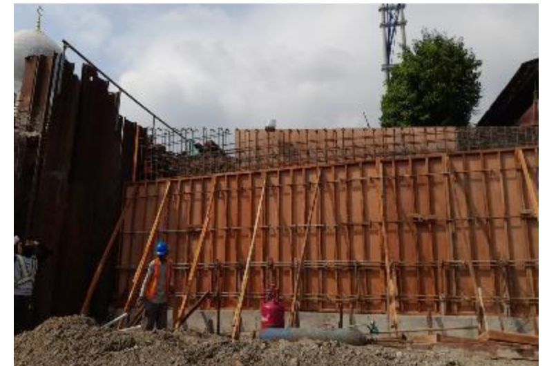
Pekerjaan Pasang begisting dan perkuatan strut dinding RW viaduct sisi selatan.
