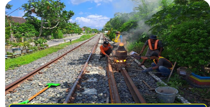
Pekerjaan pengelasan Rel R. 54
