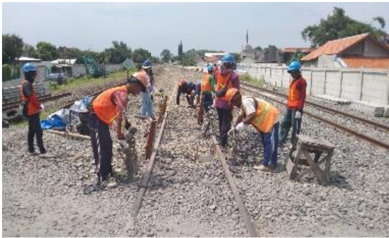
Pekerjaan Angkutan HTT km 107+075 new kanan
