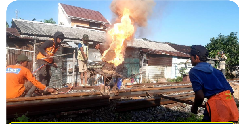
Pekerjaan Las thermit
