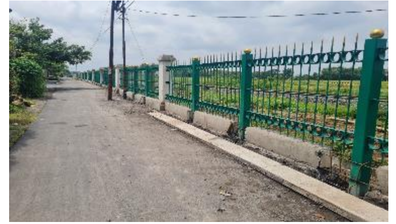
Pekerjaan Pagar Ornamen
