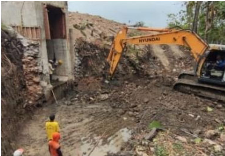
Pekerjaan lantai kerja BH.301
