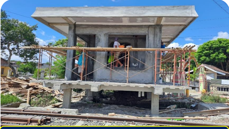
Finishing acian dan plafond gardu JPL 24
