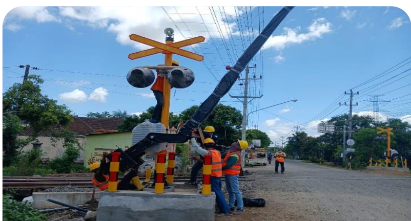
Proses Pemasangan Palang Pintu JPL 24
