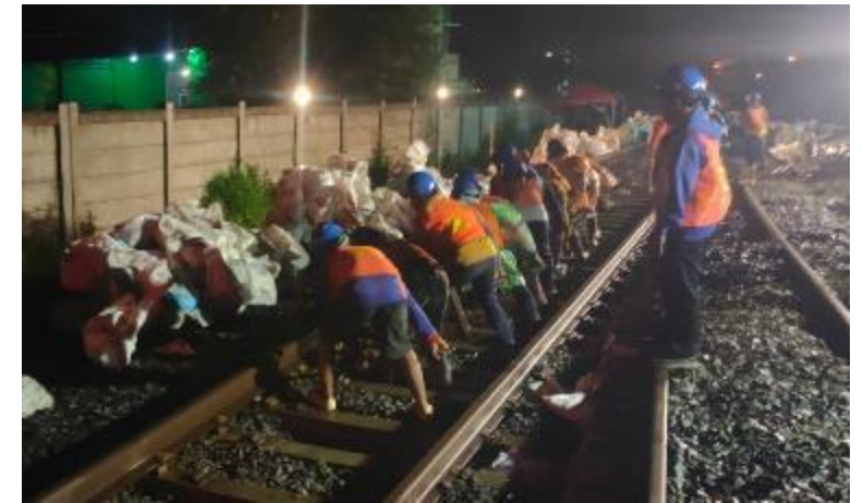
Pekerjaan SO existing ke new Track
