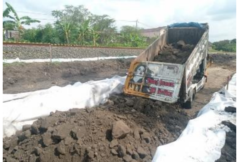
Pekerjaan Urugan Tanah Pilihan
