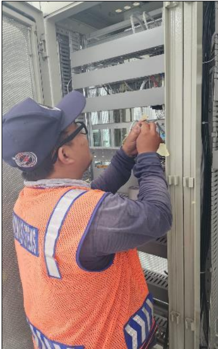
Pekerjaan Instalasi Indoor Stasiun Kalioso
