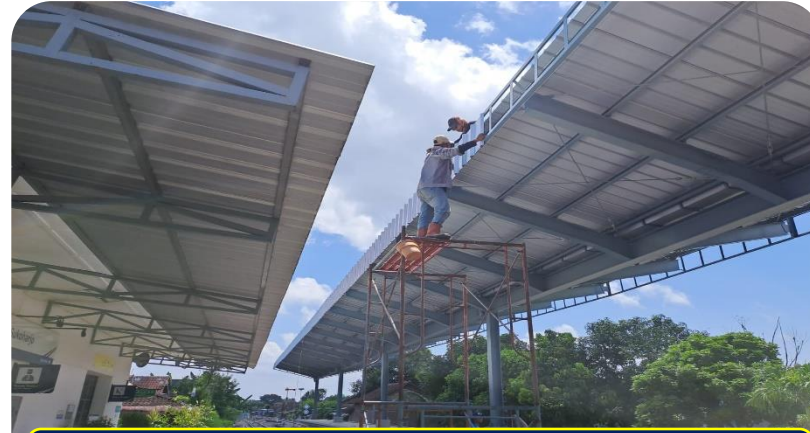
Pemasangan lisplang shelter peron St. Sukoharjo
