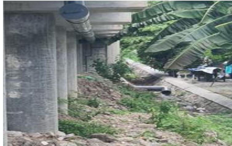
Pekerjaan Pipa drainase SOP Zona utara
