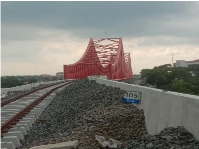
Pekerjaan pemasangan patok KM
