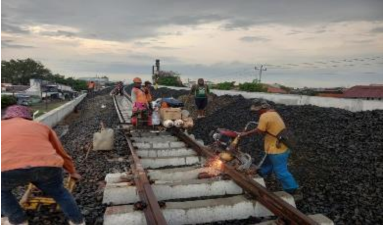
Pekerjaan Mengelas Rel R.54 Dengan Las Thermit
