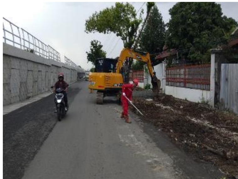
Pekerjaan drainase pracetak
