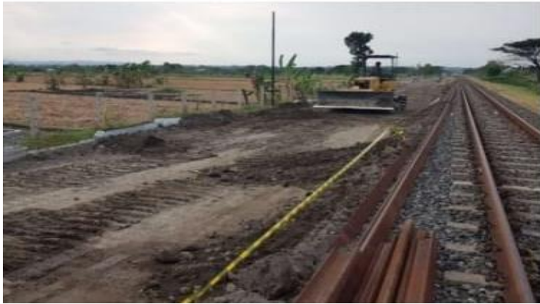
Pekerjaan tubuh baan Km.98+800-Km.99+200
