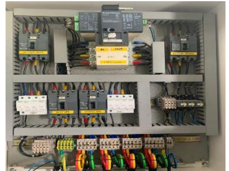
Pekerjaan Instal Catu Daya (UPS)
