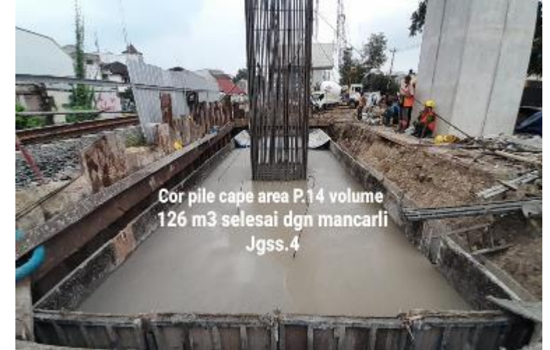
Pekerjaan Pengecoran Pilecap P.14
