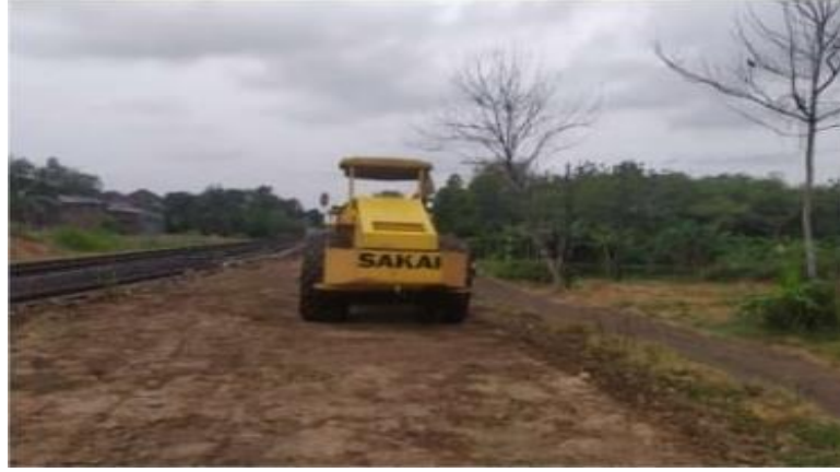
Pekerjaan timbunan Km.101+300-Km.101+450
