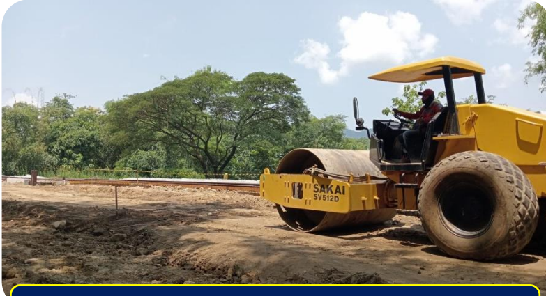
Pemadatan subbalas tubuh baan 27+450-500
