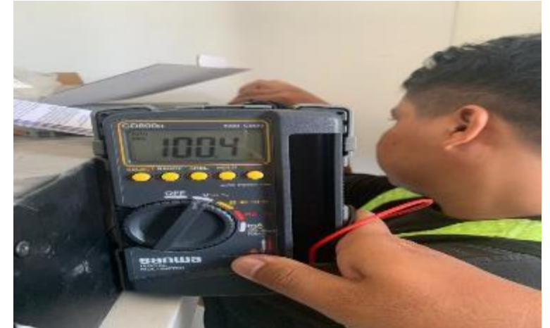
Pekerjaan Instal Catu Daya (UPS)
